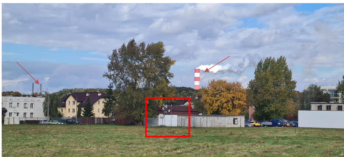
Rysunek 20 Zdjęcie pokazujące lokalizację stacji pomiarowej Płock-Politechnika w stosunku do położenia PKN ORLEN S.A.
